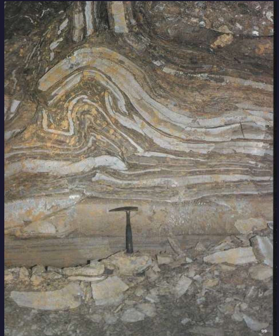
PLI LOCALISE avec FRACTURE
